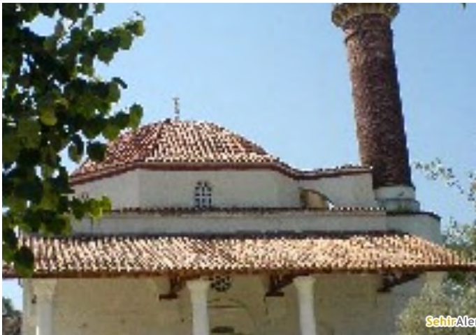
YAVUZKÖY ŞEMSİ PAŞA CAMİİ
